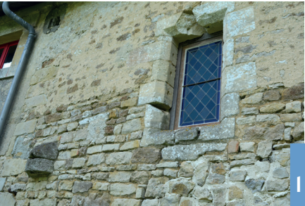
▲ Détail de l'étage de la façade nord avec la goulotte du lavabo et l'une des fenêtres, remontant à 1230, vestiges témoignant ici d'un chamber-block , au début des premiers travaux.
